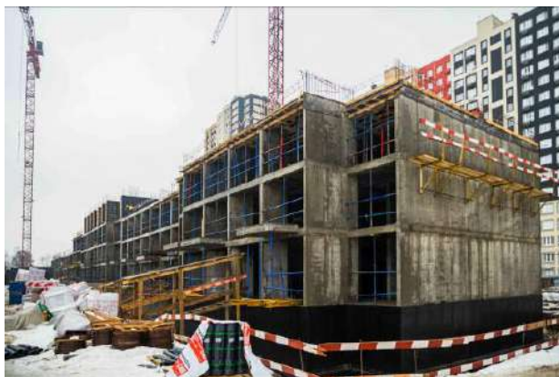
Фото 3. Общий вид корпуса 1 ЖК «Пехра»
