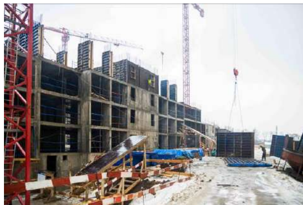
Фото 4. Общий вид корпуса 1 ЖК «Пехра»
