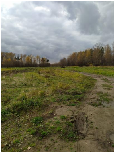
Фото 10. Общий вид подъездной дороги к объектам
