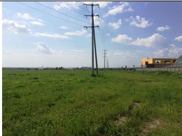
Фото 2. Вид на участок и ЛЭП
